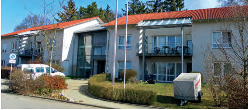
Das Wohnhaus am Spital
